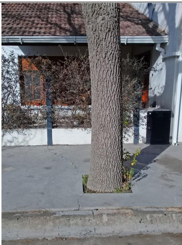
Foto 3: Cazuela de riego inexistente.
