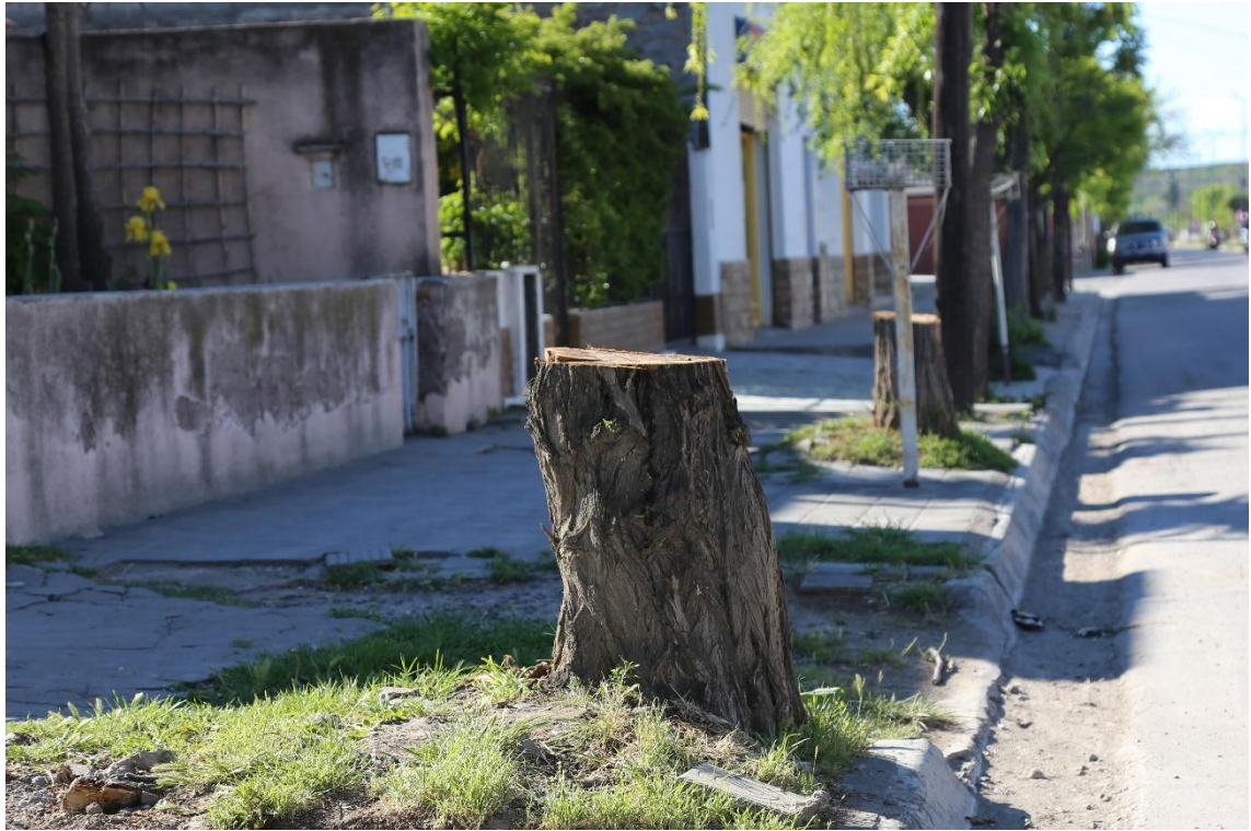
Foto 2: ejemplo de extracción no autorizada.
