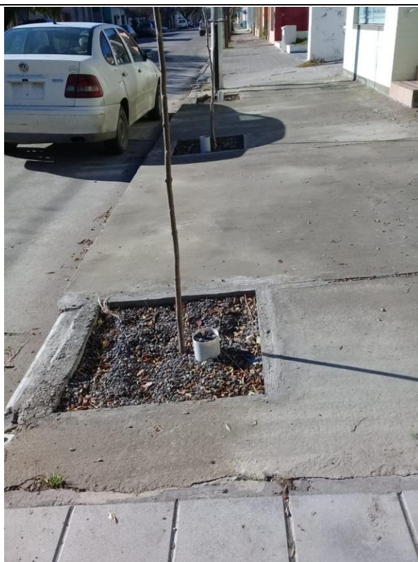
Foto 24: Cazuela con caño de riego para favorecer el mismo y evitar roturas.
